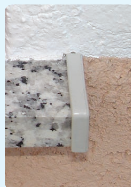
Police z zaključkom - voda ne zateka po zaključnem sloju in fasada ima trajno lep izgled.
